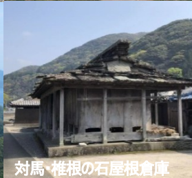
対馬・椎根の石屋根倉庫
