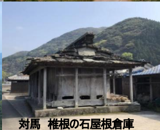
対馬 椎根の石屋根倉庫
